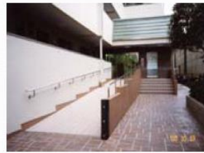
スロープ設置
