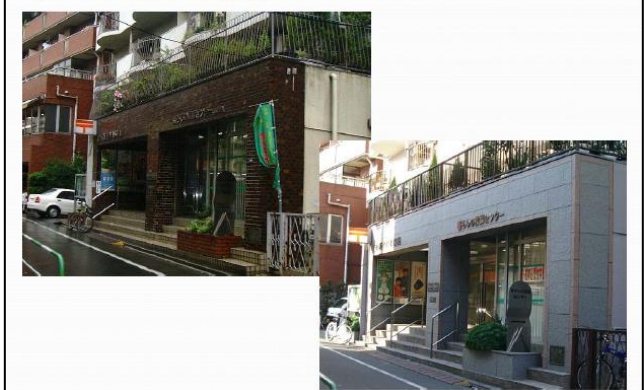
◇エントランスの改良
